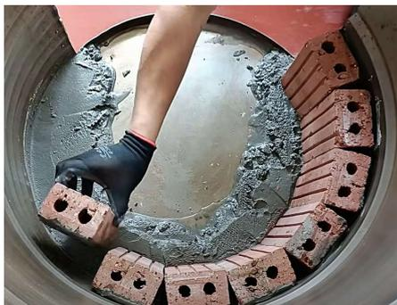
Das Innere wird zementiert und mit Backsteinen ausgekleidet. Es folgt eine weitere Schicht Zement, und darauf werden Schamottsteine verlegt. Eine Platte wird eingefügt und darauf folgt eine weitere Schicht Zement und am Rand des Gefäßes weitere Schamottsteine.
