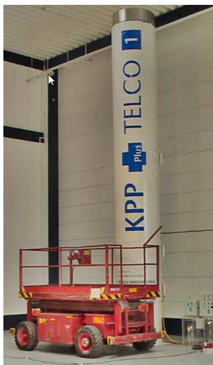
15-20-kW-Rosch-Auftriebskraftwerk bei der Montage am Geschäftssitz der Rosch GmbH in Spich.
